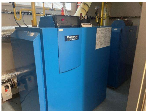
Obrázek 7 Současný zdroj tepla pro objekt – plynová kotelná
